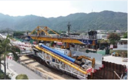
香港特區首臺 UTBM 盾構機 在中國中鐵元朗南一期填平項目榮耀始發 First U-shaped TBM in Hong Kong launched on CREC's Yuen Long South Site Formation and Infrastructure Project Site
