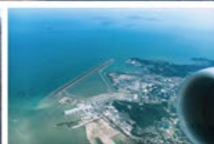
澳门国际机场扩建工程
