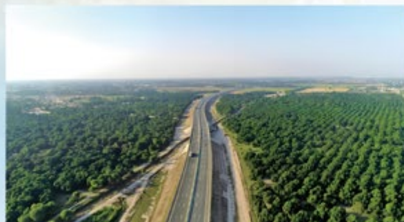
巴基斯坦 PKM 高速公路项目 Peshawar-Karachi Motorway (PKM) Project (Pakistan)
