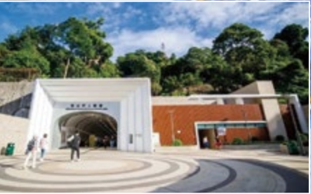
澳門城市建設和改善民生的重點工程項目 ——環嘉山步行系統設計連建造工程 Macao Guia Hill Pedestrian Tunnel-a key project for urban development and improving people's livelihood
