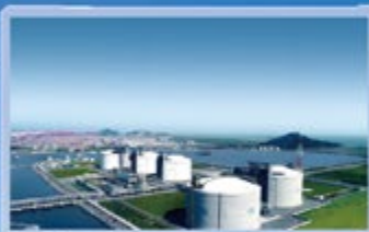
上海洋山港LNG输配工程 Shanghai Yangshan Port LNG Transmission & Distribution Project
