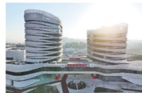
埃塞俄比亚援非盟非洲疾病预防控制中心总部 China-aided Africa Center for Disease Control and Prevention Headquarters Project
