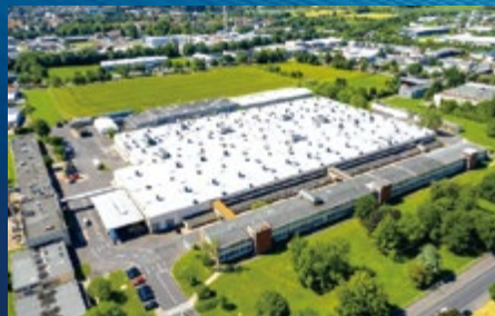
国轩高科芝加哥工厂扩容项目 Gotion Chicago Factory Expansion Project
