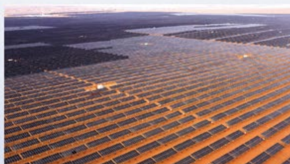
内蒙古库布齐沙漠新能源基地 Inner Mongolia Kubuqi Desert New Energy Base PV Project
